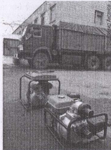
Таковыми мотопомпами откачаны тонны трансформаторного масла
